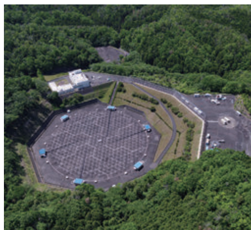
滋賀県甲賀市信楽町に設置されているMULレーダー。アンテナ直径は103m。
