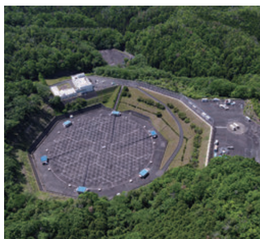
滋賀県甲賀市信楽町に設置されているMUレーダー。アンテナ直径は103m。
