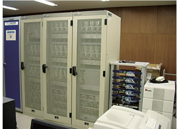
「MU レーダー観測強化システム」の超多チャンネルデジタル受信システム
